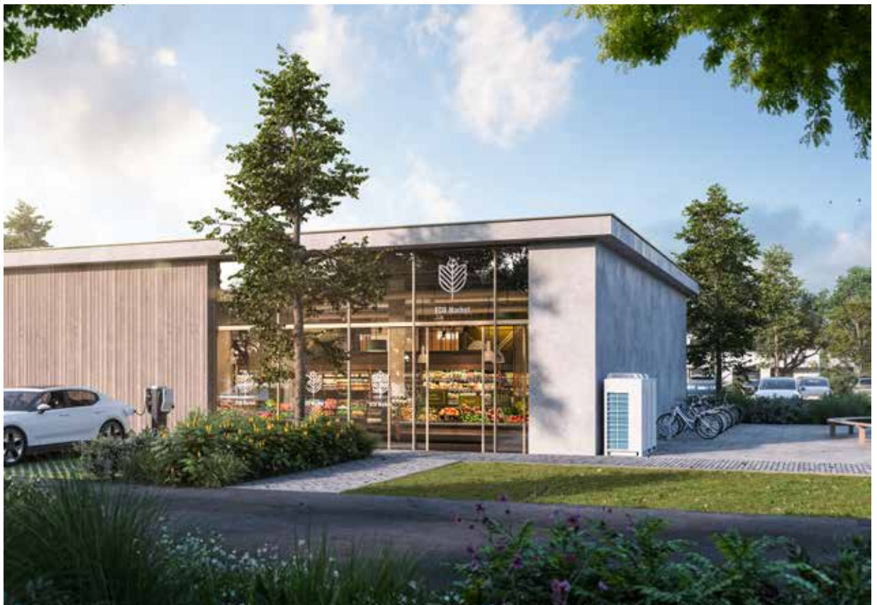
Exemplo de instalação de VRV a CO 2 para supermercado
