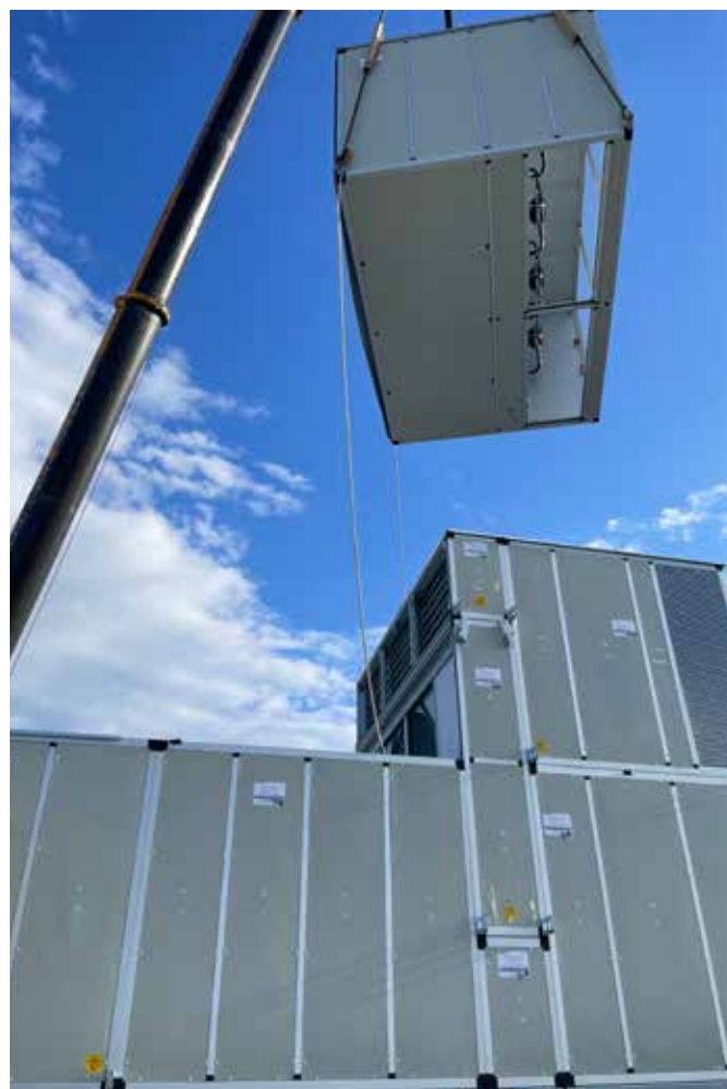
Instalação de UTA Profissional
