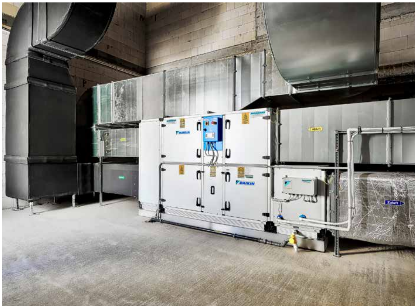
Instalação de UTA Modular R
