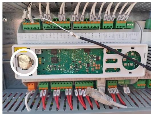
Tenha cuidado para não danificar a cobertura de plástico. A nova bateria deve ser colocada no suporte apropriado da bateria, destacado na figura, respeitando as polaridades indicadas no próprio suporte.
